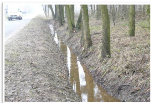
Ryc. 7. Rów odprowadzający w okolicy miejscowości Zielkowice
