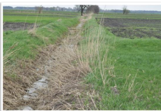
Ryc. 8. Rów odprowadzający w okolicy miejscowości Guźnia
